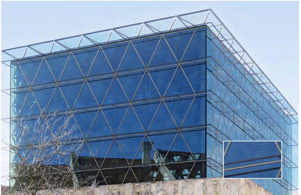
Der Glaskubus des Jüdischen Zentrums von Wandel Hoefler Lorch + Hirsch in München ist umgeben von einer stählernen Stützkonstruktion und einem Bronzegewebe. Ein Dreiecksmuster aus Davidsternen sorgt durch das Spiel von Licht und Schatten im Gebetsraum für eine besondere Atmosphäre.
