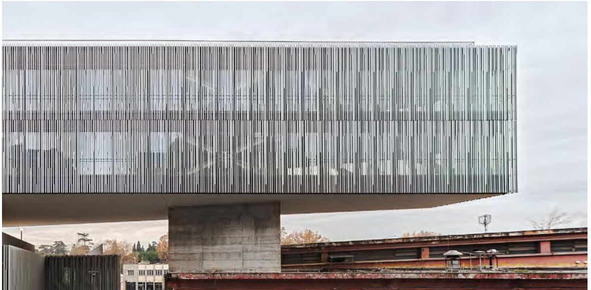
Die Città del Sole («Sonnenstadt») in Rom des Architekturbüros Labics ist eine Mehrzweckanlage mit öffentlichen und privaten Funktionen. Sowohl die Fassadengestaltung aus Aluminiumprofilen als auch die transluzenten gläsernen Lamellen an den unterschiedlichen Gebäuden sorgen gleichermaßen für Sonnen- wie auch für Vogelschutz.
