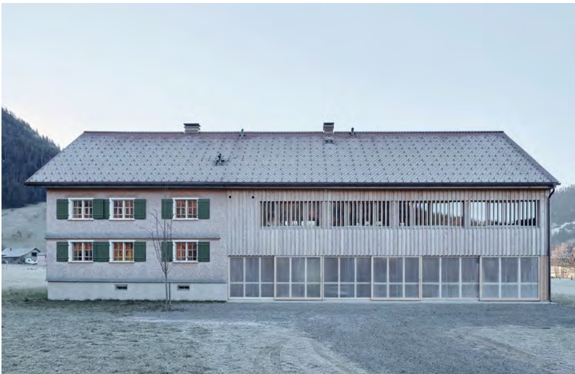
Im Zuge einer Umnutzung haben gruber locher architekten bei der Sanierung des denkmalgeschützten Hauses Grossenbündt in Hittisau die Erschliessungsflächen hinter einer semitransparenten Raumschicht zusammengefasst. Die Struktur der traditionellen Holzfassade wird aus Sonnenschutzgründen über die langen Fensterbänder im Obergeschoss weitergeführt, während die klassischen Kastenfenster des Wohntraktes erhalten blieben. Vögel können diese Materialien und Strukturen gut erkennen.
