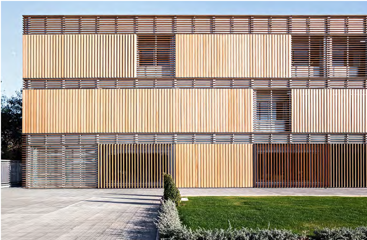
Im Westblock des Centre d'Idiomes de la Universitat de València des Architekturbüros Arkitera SLP bestimmt die Kombination von feststehenden und beweglichen Sonnenschutz-Lamellen die Fassadenstruktur.
