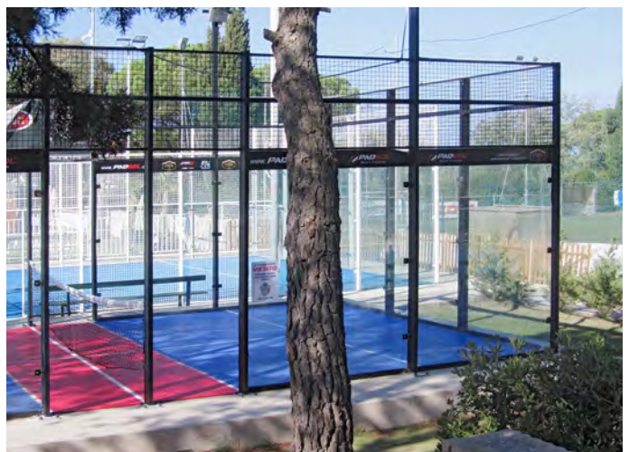
Beim Padel-Tennis sind die Spielfelder teilweise von transparentem Kunststoffglas umgeben. Aus Spanien, Italien und anderen europäischen Ländern gibt es Nachweise zahlreicher Vogelkollisionen an solchen Begrenzungswänden.
