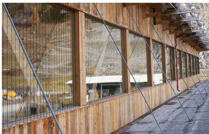
Nach wiederholtem Vogelanzprall an den spiegelnden Fenstern einer Werkhalle in S-charf wurden nachträglich im Abstand von 8–10 cm schwarze Nylonschnüre gespannt. Im Anschluss an die Nachrüstung wurden keine Vogelkollisionen mehr dokumentiert.
