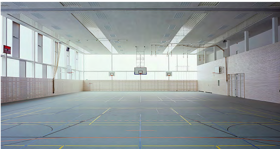
Die Gebäudehülle der Ballspielhalle Ingolstadt von Fink+Jocher besteht aus einer Profilbauglaskonstruktion, die zwischen ihren beiden Glasprofilschalen mit transluzenter Wärmedämmung gefüllt ist. Diese sorgt für ausreichend Lichteinfall ohne störende Schlagschatten auf dem Spielfeld.
