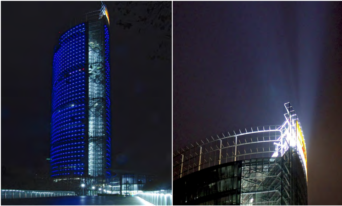
Effektbeleuchtung hinter der äusseren Glasfassade und angestrahlte Firmenlogos auf dem Dach locken am Bonner Post Tower Zugvögel ins Verderben. Solche exponiert leuchtenden Werbeflächen, Baukräne, Flugsicherheitsbeleuchtung und andere Lichtquellen in grösserer Höhe befinden sich in der Flugbahn von Zugvögeln und besitzen ein bisher oft verkanntes Gefahrenpotenzial.
